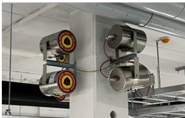
Aerosolsläcksystem skyddar större tekniska utrymmen samt batterilagringssystem.
