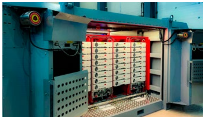
Aerosolsläcksystem skyddar större tekniska utrymmen samt batterilagringssystem.
